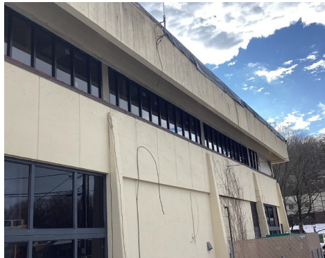
Instalación de nuevas ventanas
