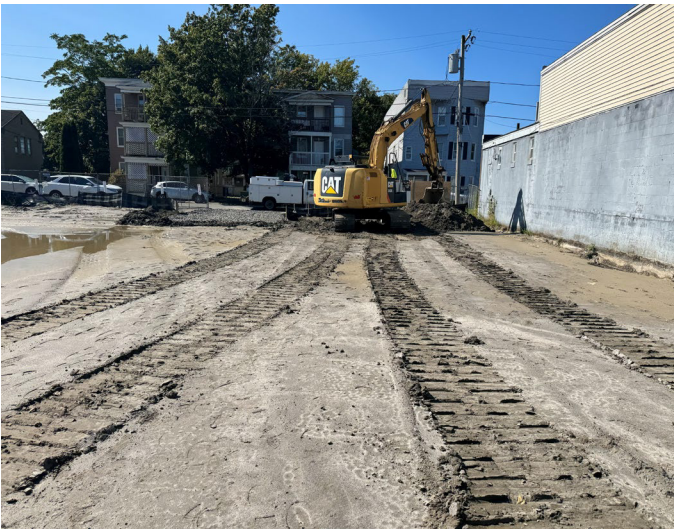
Antes de la instalación
