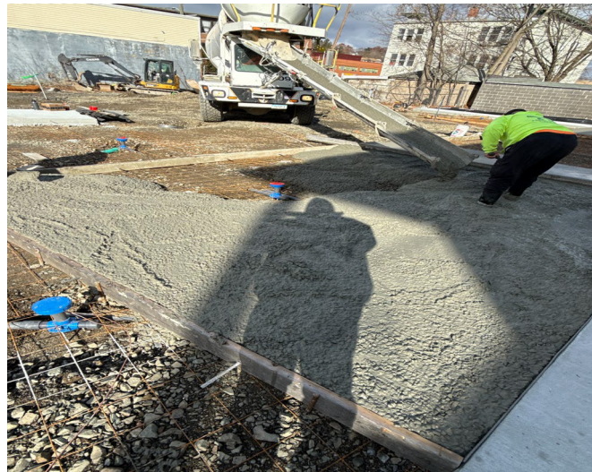
Vertido de hormigón para la zona de juegos acuáticos
