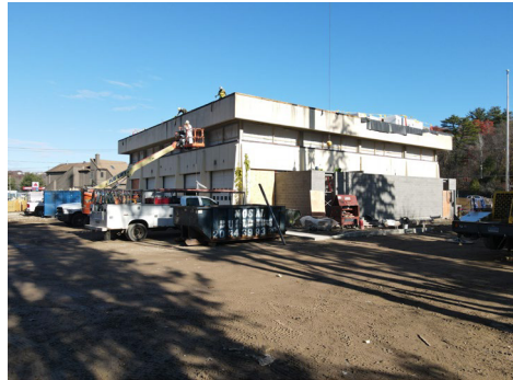
Preparación para la instalación de ventanas
