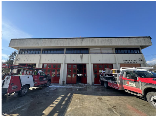
Después de instalar las nuevas puertas rojas
