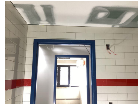
Colocación de nuevos azulejos y pintura interior
