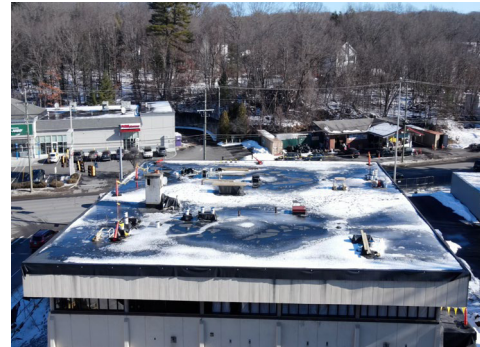
Instalación de la nueva cubierta
