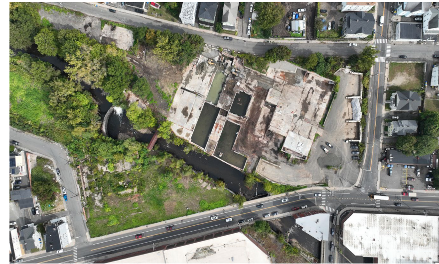
Tras la retirada del montón de escombros
